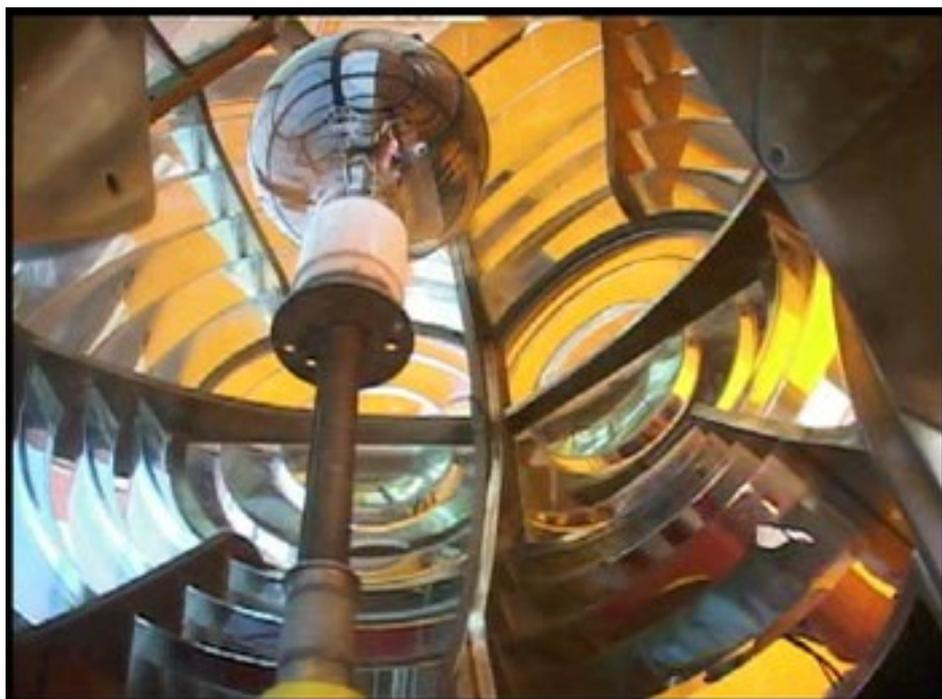
En sus albores, la linterna funcionaba con aceite de oliva, traído en barcos de guerra una vez por mes, junto a los víveres que auxiliaban a la dotación del faro. En 1955 se sustituyó la máquina Fresnell, fabricada en Francia que había prestado servicios por 85 años, por otra de igual marca que permanece en funcionamiento. Como antaño, tres torreros, se encargan de su conservación y funcionamiento.
