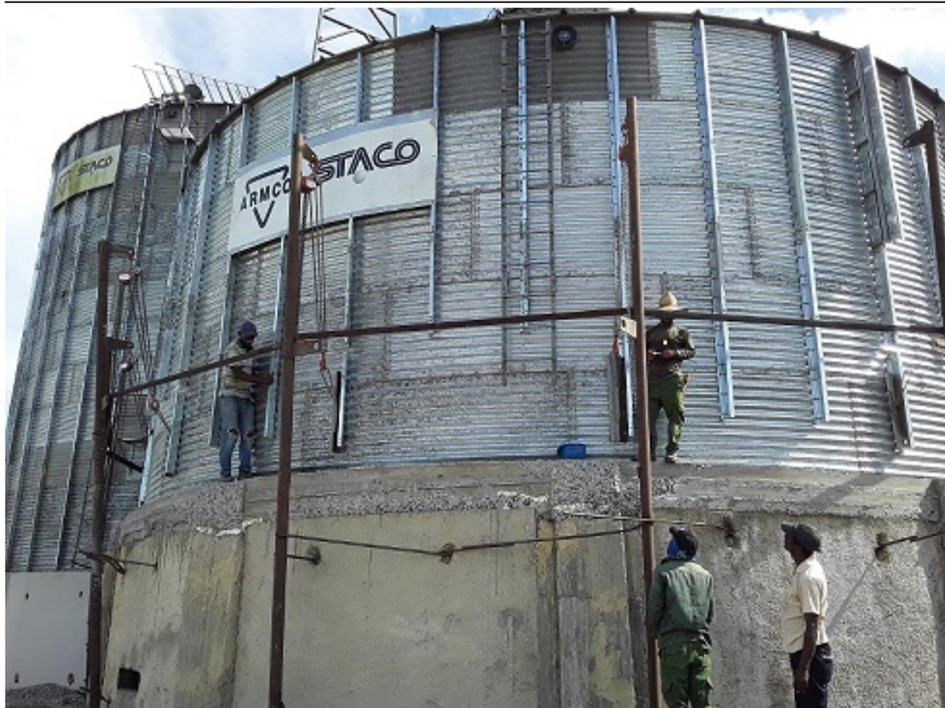
En la Unidad Empresarial de Base Industrial (UEBI) Victoria de Girón, del pinareño municipio de Consolación del Sur, avanzan las labores de montaje de cuatro silos que permitirán aumentar la capacidad de almacenamiento de arroz en ese sitio.
